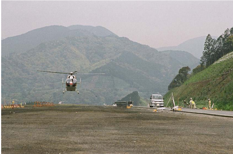
写真－２ 建設中の第２東名高速道路における離着陸訓練の様子
