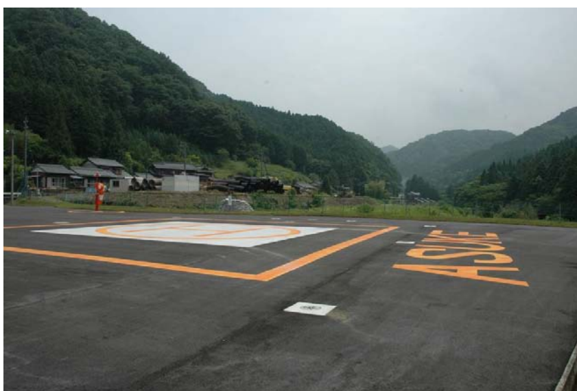
写真－1 足助消防署に設置されたヘリポート
