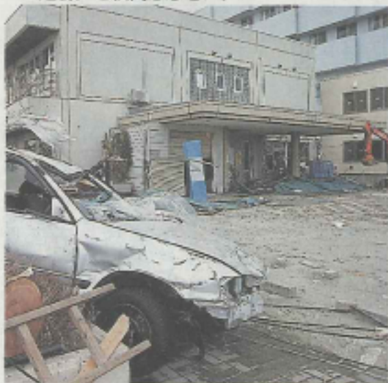
津波で大破した石巻市立病院（奥の建物）と夜間急患センター
